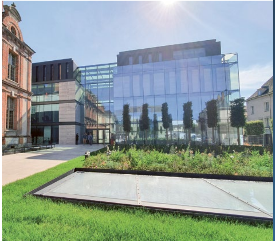
L'hôtel d'Agglomération est doté de 26 sondes géothermiques, plongées à 146 mètres de profondeur.
