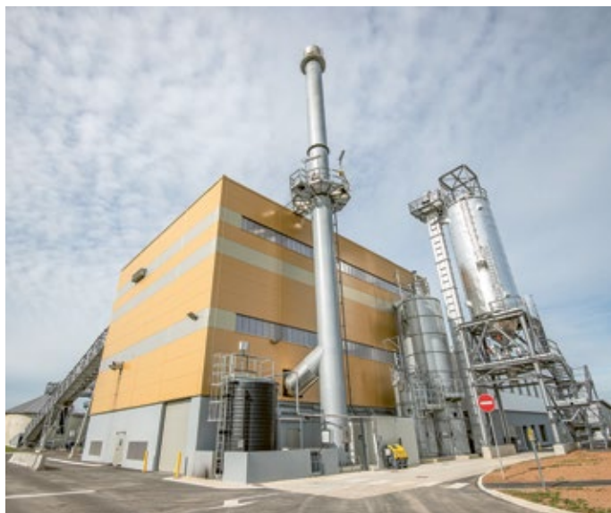
L'usine biomasse de Chartres métropole produit simultanément de l'électricité et de la chaleur à partir de bois de récupération.
