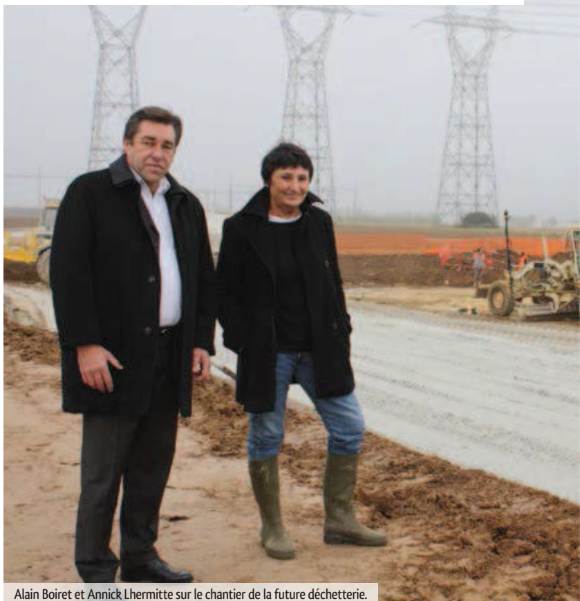
Alain Boiret et Annick Lhermitte sur le chantier de la future déchetterie.
