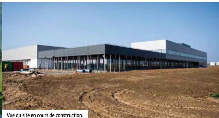
Vue du site en cours de construction.
