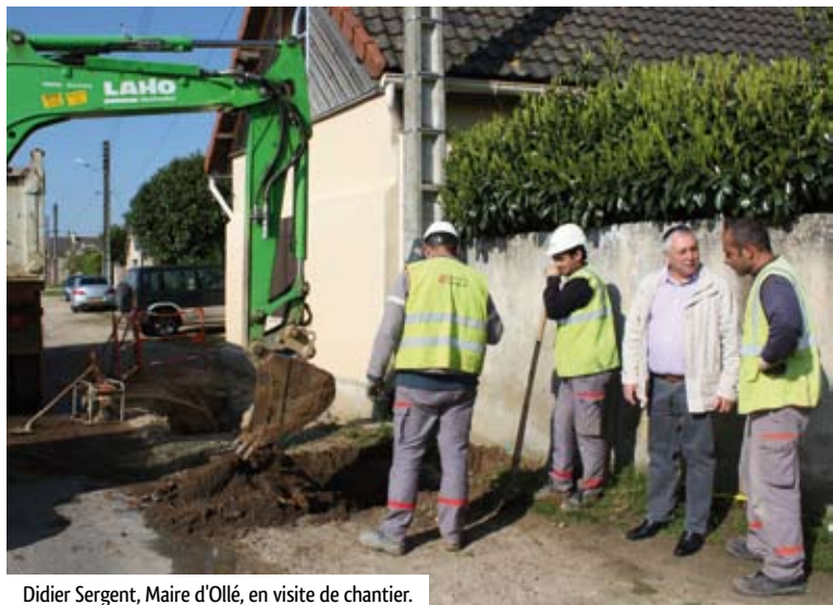
Didier Sergent, Maire d'Ollé, en visite de chantier.
