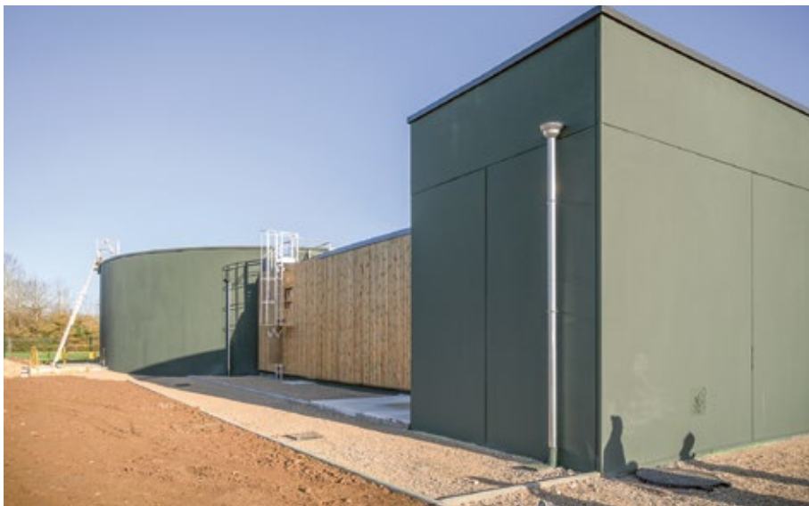
Le nouveau réservoir d'eau de Fontenay-sur-Eure, en cours de construction, sera mis en service en septembre prochain.
