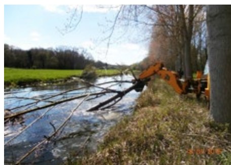
Enlèvement d'embâcle à Saint-Prest.
