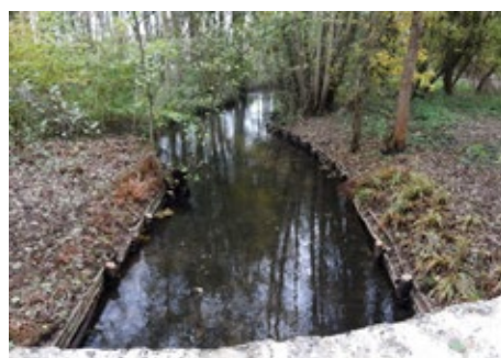
Etat des lieux d'ouvrage à Barjoville.
