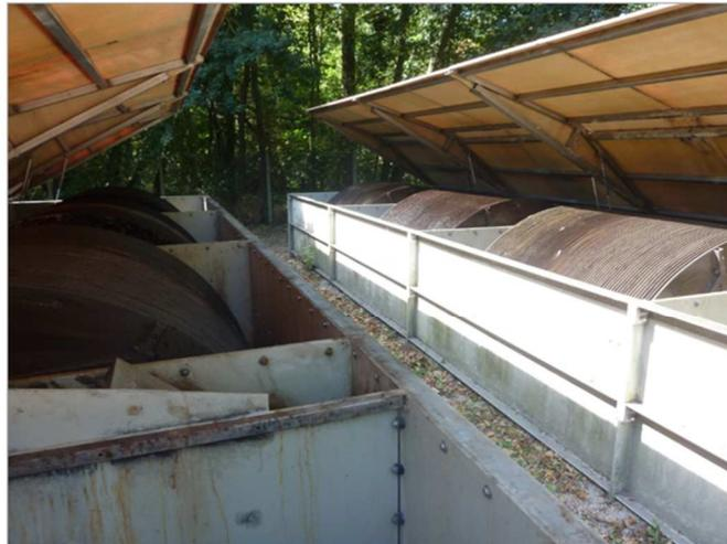
Maintenance corrective à réaliser sur les paliers du biodisque n°1 (attente de devis)
