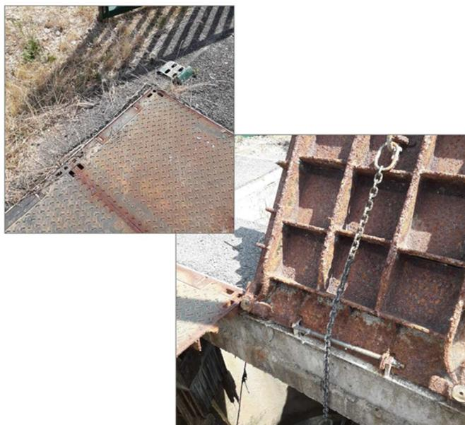
Nécessité de changer les trappes (inox ?) et de mettre des barres anti-chutes
