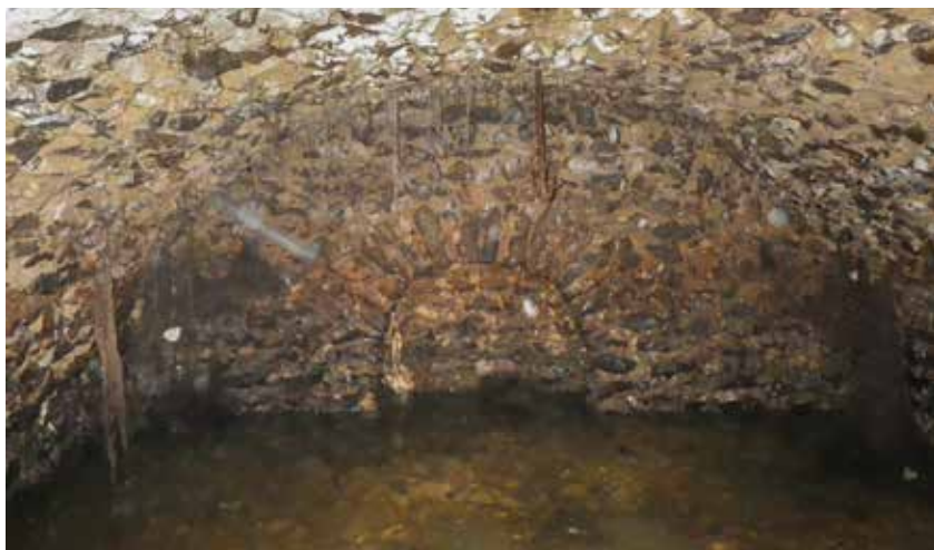
Vues de la cave depuis l'intérieur et de l'extérieur, avec l'orifice ancien par lequel l'exploration interne a pu être réalisée.
