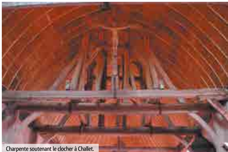
Charpente soutenant le clocher à Challet.
